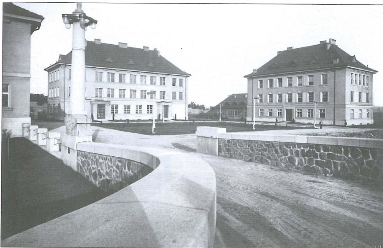
Tzv. Laboratorní náměstí s budovami č. 2 (bakteriologie) a 3 (sérologie).
